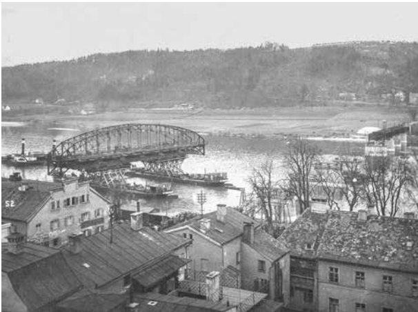
Die neue Donaubrücke befindet sich im Bau: Mit Schleppschiffen wurde am 12. Oktober 1948 der 240 Tonnen schwere Mittelbogen eingeschommen. (Foto: StAV, Nr. 871)
