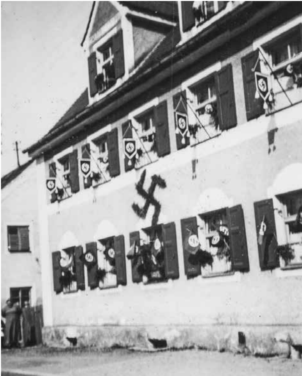
Das Wohnhaus in der Prof.-Scharrer-Straße diente zur Unterbringung von Displaced Persons. (Foto: Sammlung K. Bradl)
