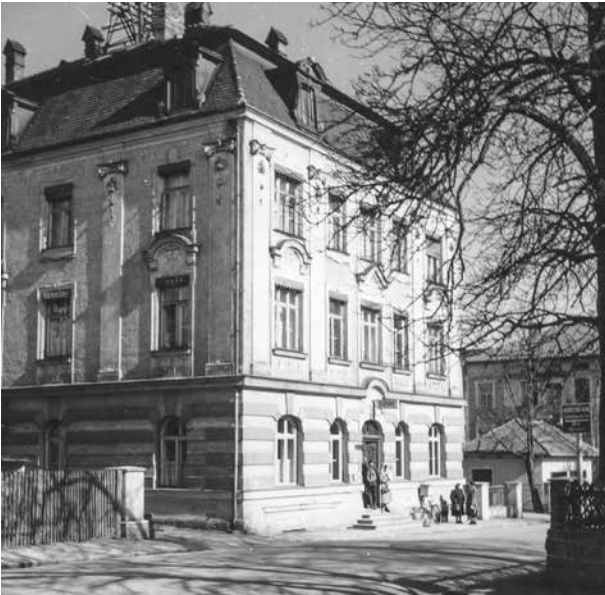
Das Postamt in der Bahnhofstraße zählte zu den ersten Gebäuden in Vilshofen, das von den Amerikanern besetzt wurde. (Foto: StAV)
